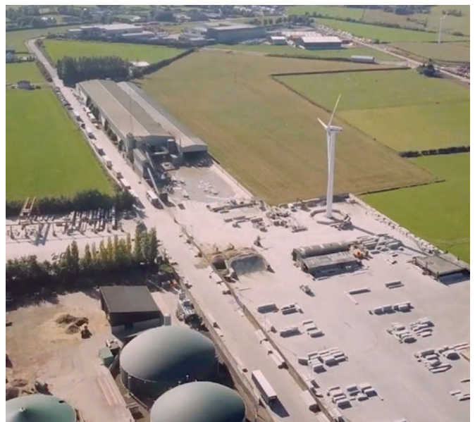
Vista aérea de la planta de producción de Creagh Concrete
